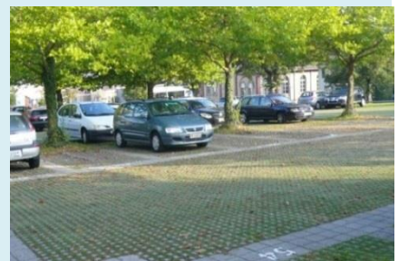
Stationnement en dalles alvéolées enherbées
