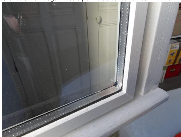
Autre exemple de renforcement du vitrage (DV traditionnel)
