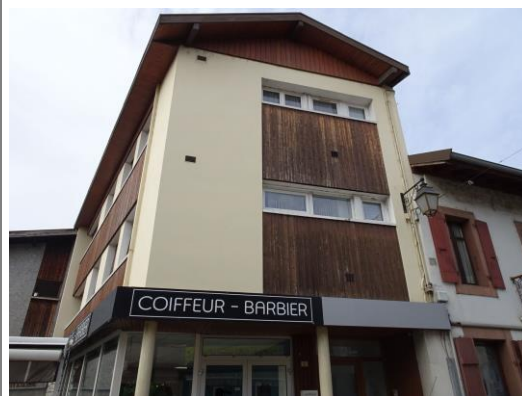
Construction moderne, après 1948 à Basse Bonne Dans ce cas il s'agit d'un mur maçonné recouvert en partie d'un bardage bois
