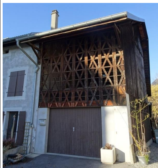
Bâtiment antérieur à 1948, Haute Bonne Caractéristiques des granges et des parties dépendances des anciennes fermes (hanger, granges, séchage des récoltes...) Ce sont des structures bois recouvertes d'un bardage bois plein ou ajouré. Celui-ci a une mise en œuvre savante : c'était l'ancien séchoir à draps de la maternité voisine, aménagé dans une ancienne grange.
