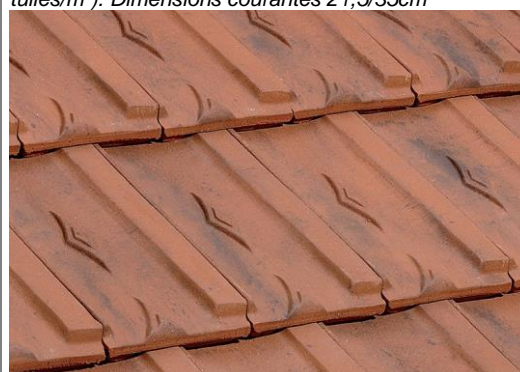
Tuile mécanique traditionnelle, losangée (13 à 20 tuiles/m²). Dimensions courantes 21,5/35cm
